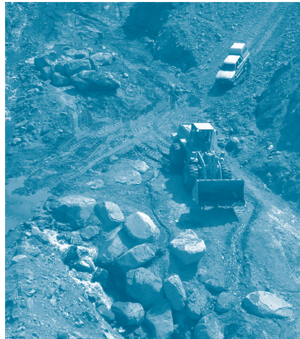
Figura 10.- Enrocado ciclópeo con junta tomada con suelo cemento
